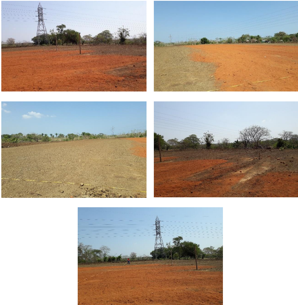
Fig 1-5. Zona de intervención para cancha, se observa relleno por sectores, sin compactar. Arquerías y malla no se encontraron.
