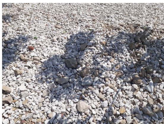
Fig 60-66. Zona de intervención para parqueadero, se observa material de gran tamaño por fuera de las especificaciones contratadas.
