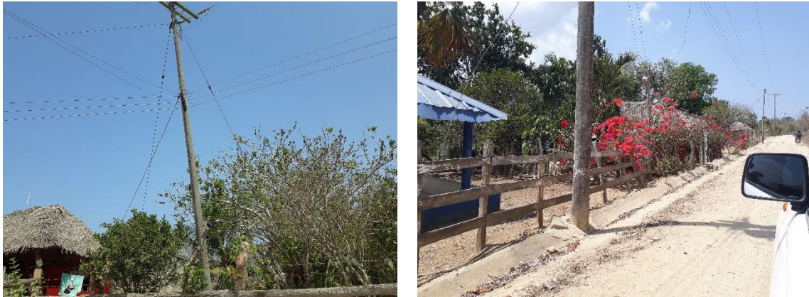
Fig 10-13. Postes alineados, ya se encuentran desplomados nuevamente varios de ellos
